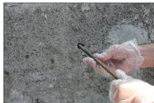
۵ - جای گذاری آرماتور در حفره به روش پیچشی
