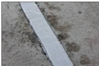
۹ - درز انبساطی آماده جهت عملیات کیورینگ (Ready For Curing)
