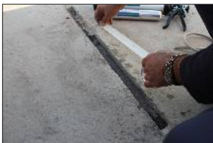
۲ - عملیات Trimming (چسباندن چسب کاغذی در اطراف درز)
