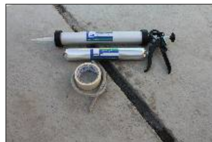
۱ - تجهیزات لازم جهت پر نمودن درز انبساطی با ESA.Pu-Mastic
