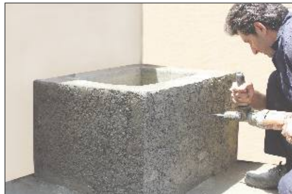
۱ - اقدام به سوراخ نمودن مخزن آب ( جهت شبیه سازی نشت منفی)
