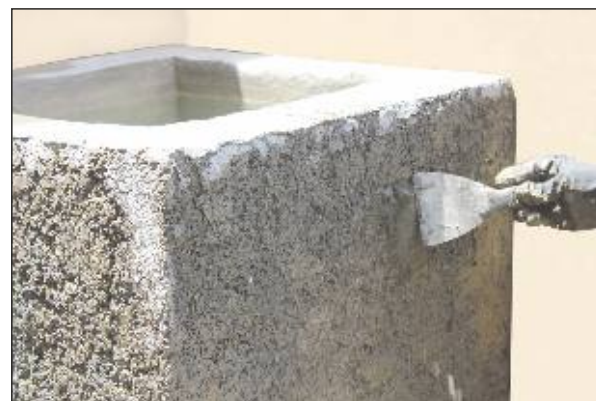
۵ - مسطح نمودن و زدودن قطعات سست
