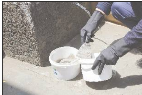
۳ - اختلاط ESA.PLUG با آب قابل آشامیدن
