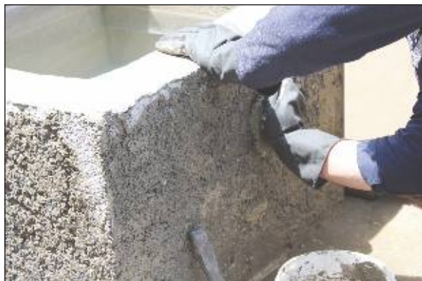
۴ - اعمال خمیر ESA.PLUG و نگه داشتن به مدت ۱۵ ثانیه
